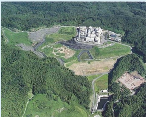
日の出二ツ塚廃棄物広域処分場
