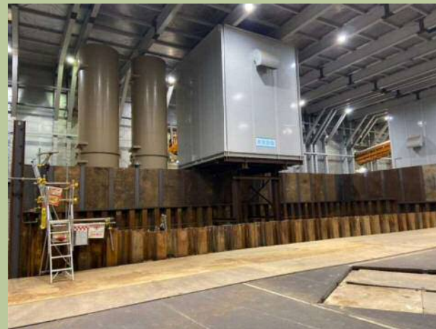
Bランプ土砂ピット (令和4年11月17日)
