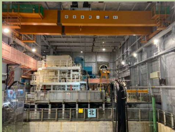
Bランプ防音ハウス内 (令和4年11月17日)
