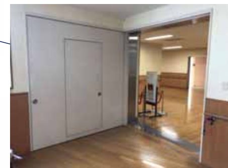
特別教室エリアの防火扉
