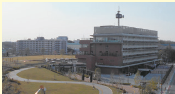
三鷹中央防災公園・元気創造プラザ
