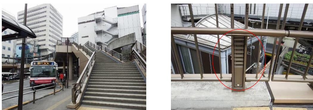
写真 2-7 ペDESTリアンデッキの現況照明
