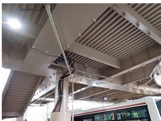
写真 1-1 軒天化粧パネル構造
