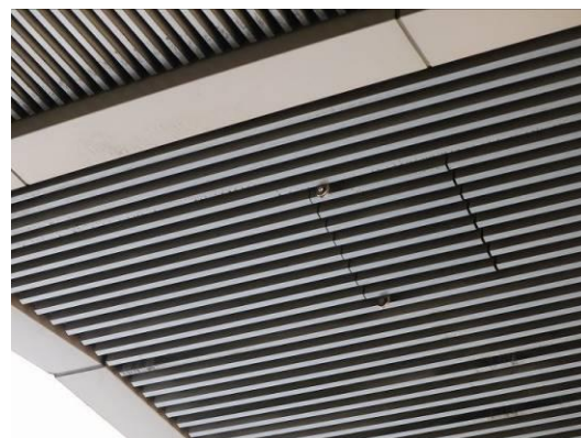
写真 1-1 軒天化粧パネル構造
