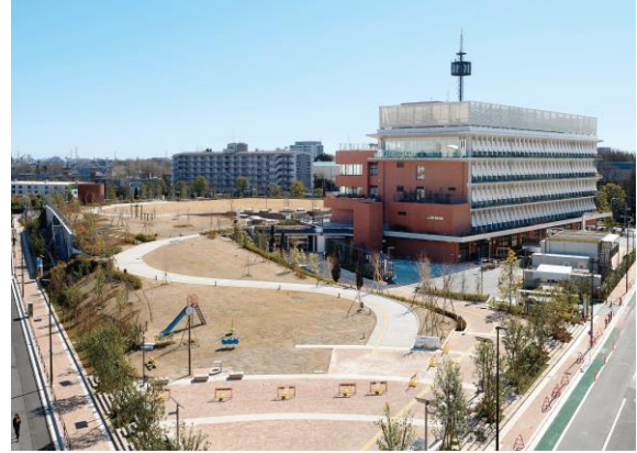
三鷹中央防災公園・元気創造プラザ
