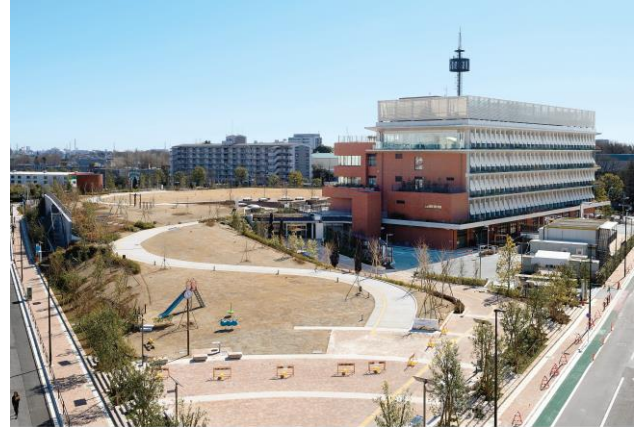
三鷹中央防災公園・元気創造プラザ
