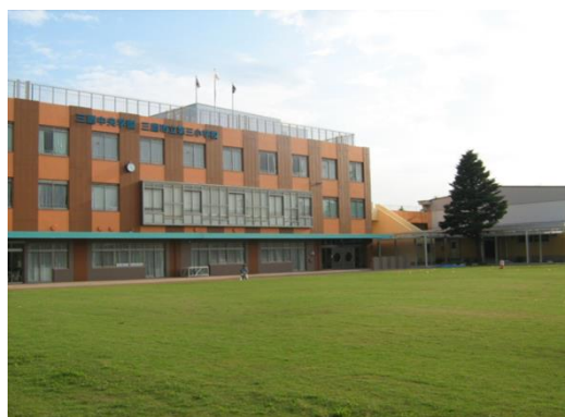
▲建替え後の第三小学校校舎
