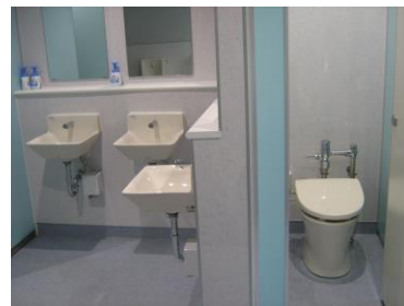
▲トイレ改修後の井口小学校
