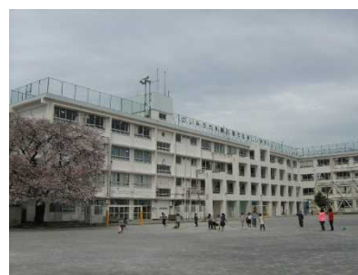
▲長寿命化改修後の第二小学校
