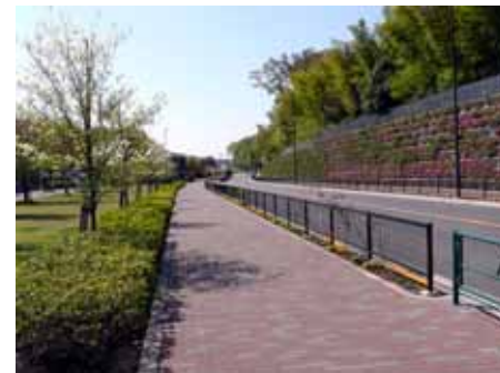
電線が地中化されている天文台通り
