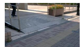
スロープなど道路との段差を解消する設備の設置
