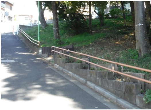
手すりを設けた坂道(中原)
