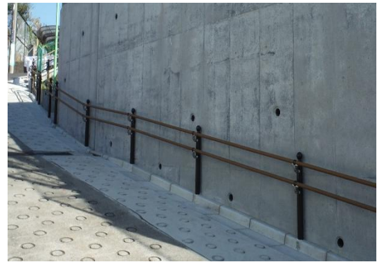
手すりを設けた坂道(中原)
