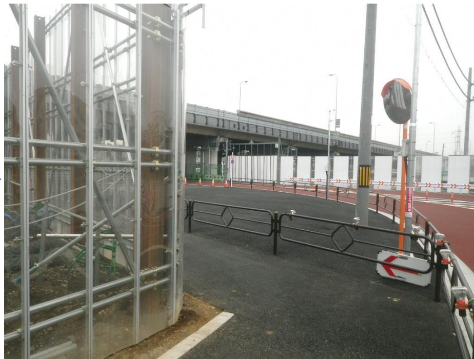
対応後: 仮囲いの角を無くし、見通しを改善
