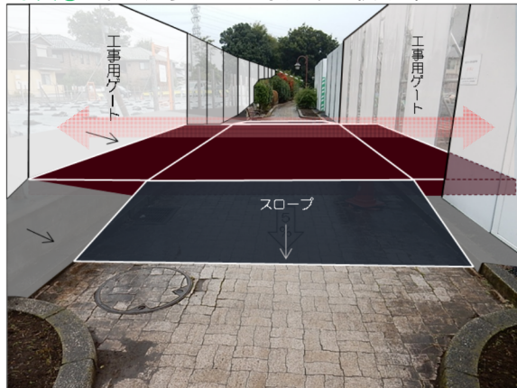
写真① 中川遊歩道の工事車両横断部イメージ
