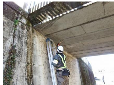
■橋梁の定期点検の状況
