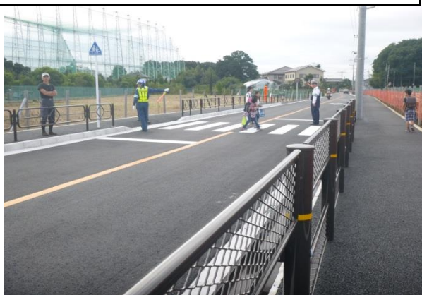
北野中央通り付け替え道路における 交通誘導員による通行の誘導
