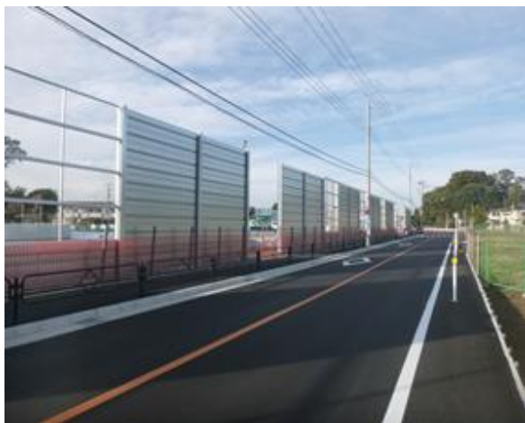
防音パネルが設置された北野中央通り付け替え道路
