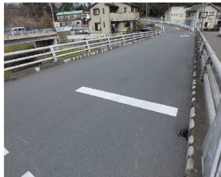
写真 4-17 橋面(舗装・地覆)補修状況 (2-1_相曽浦橋 H29 補修)
