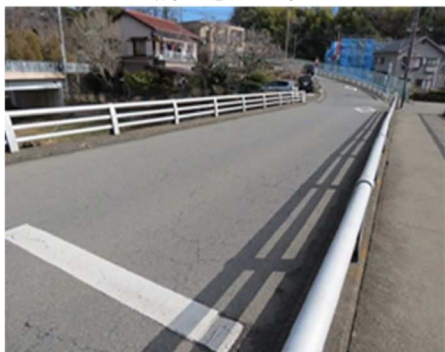
写真 4-17 橋面(舗装・地覆)補修状況 (2-1_相曽浦橋 H29 補修)
