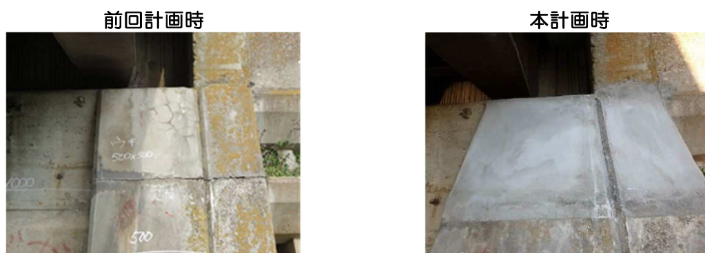
写真 4-16 下部工補修状況 (8_羽沢橋 H31 補修)
