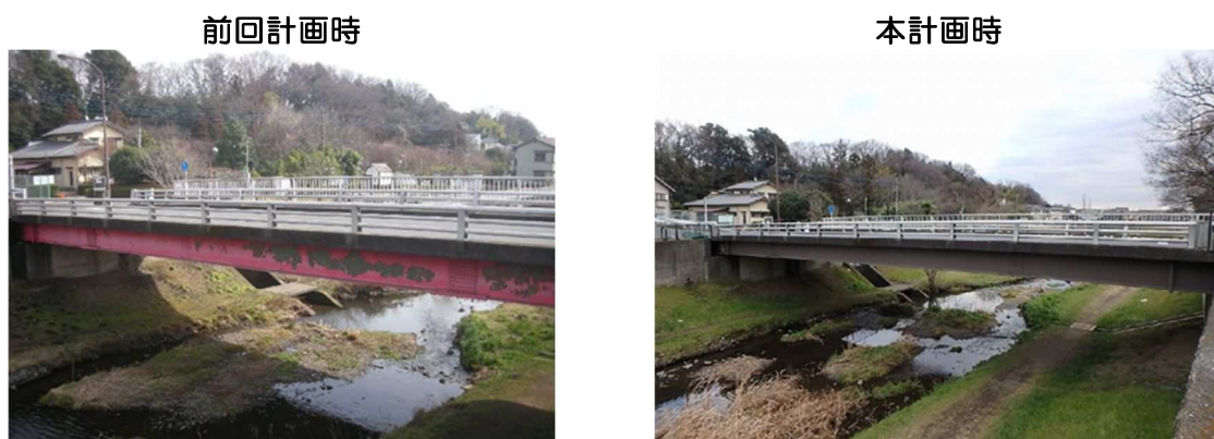
写真 4-14 主桁補修状況 (2-1_相曽浦橋 H29 補修)
