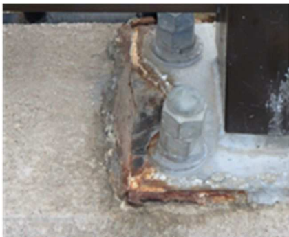
写真 4-12 高欄・防護柵損（羽沢橋）
