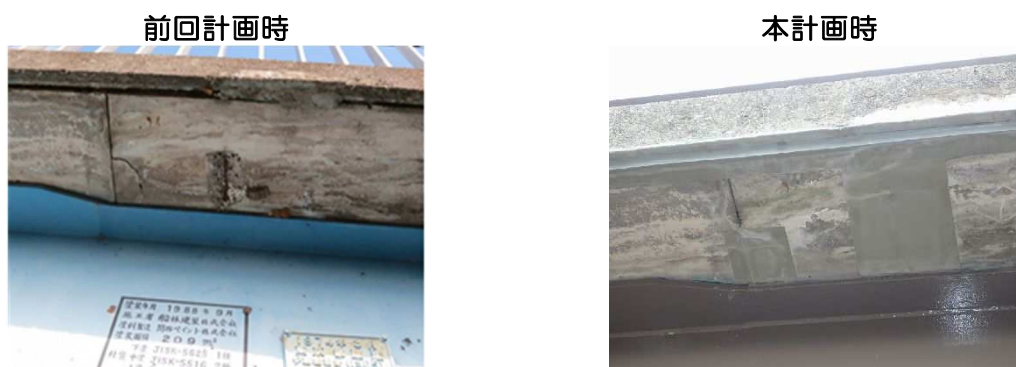
写真 4-15 RC 床版補修状況 (2-2_相曽浦橋(歩道部) H30 補修)
