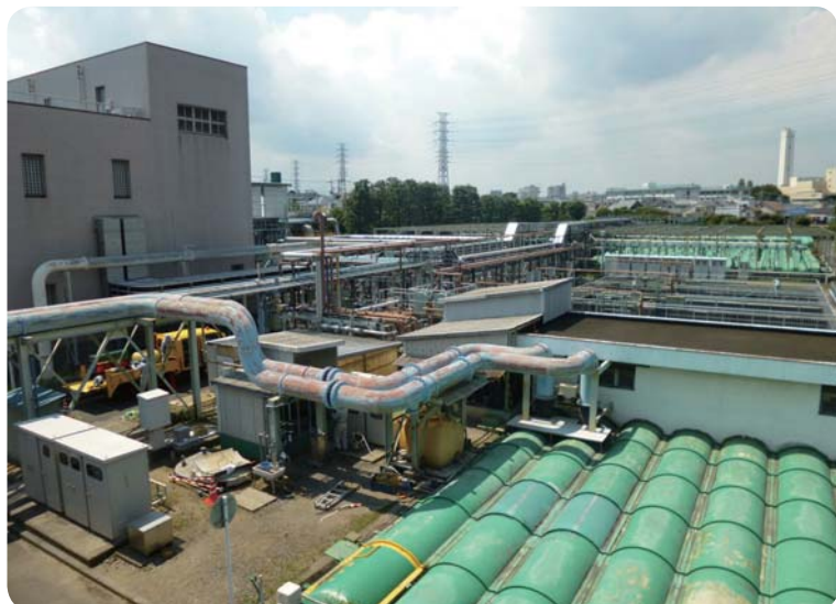
東部水再生センター
