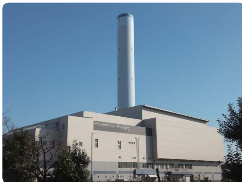
クリーンプラザふじみ
