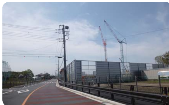
東京外かく環状道路の工事風景
