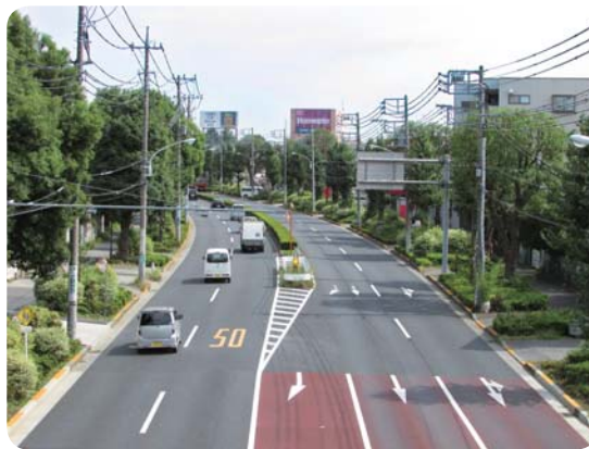
三鷹3・2・2号 (東八道路)
