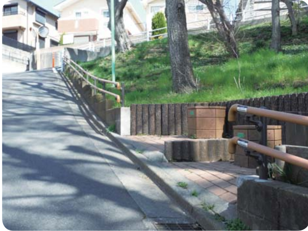
急傾斜地のバリアフリー化（中原地区）
