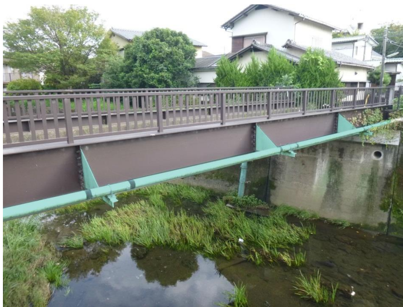
一般的な管路の色彩（谷端二の橋）
