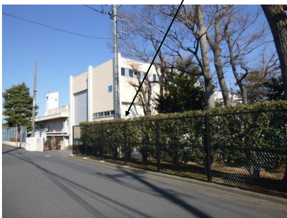
東部水再生センター
