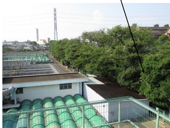
東部水再生センター
