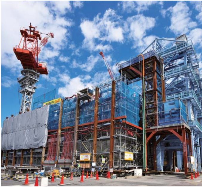
東名JCT立坑状況
