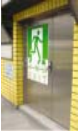
首都高速中央環状新宿線の例
