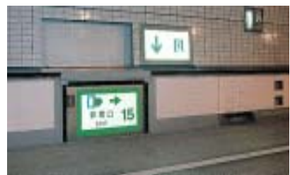
路面下への非常口(路面から)
