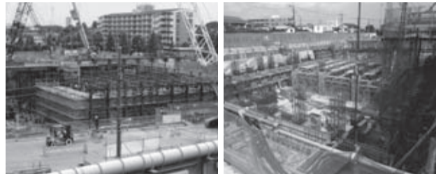
工事現場の様子
