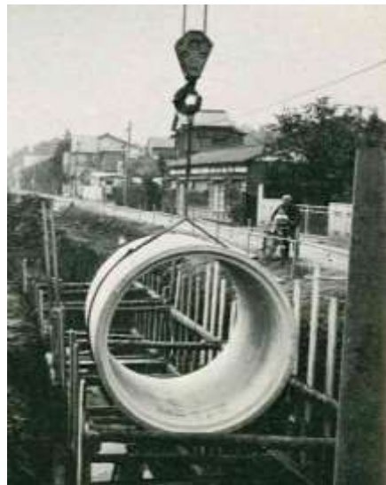
【建設当時の工事のようす】
