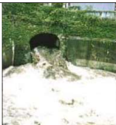
雨天時の川への越流状況
