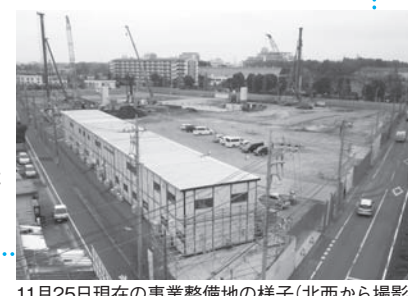
11月25日現在の事業整備地の様子(北西から撮影)
