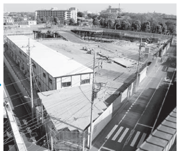
4月15日現在の工事現場
