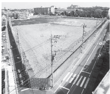
着工前の工事現場
