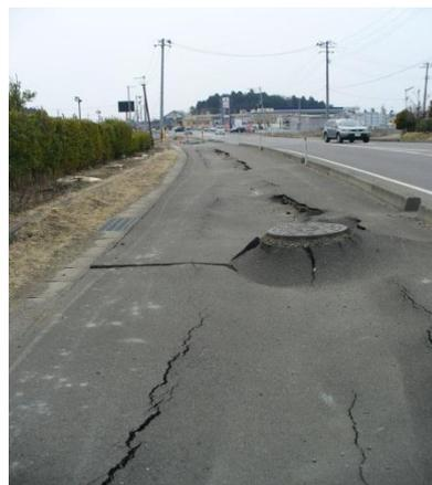
東日本大震災によって突出したマンホールと沈下した路面
