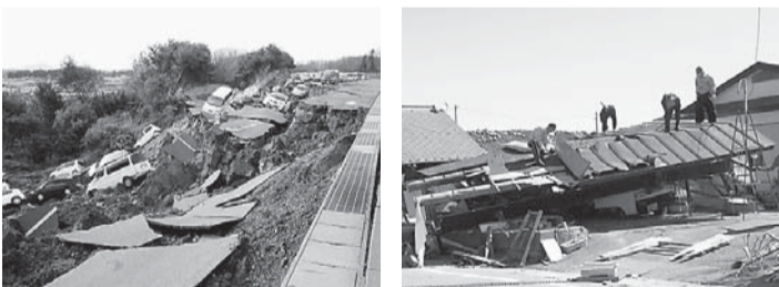
矢吹町の被災状況(矢吹町ホームページから)
