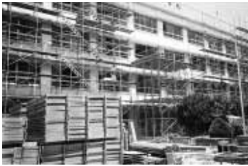
学校の耐震補強工事
