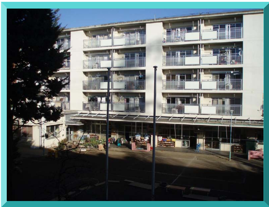
■都営住宅の1階部分に設置された保育園（南浦西保育園）
