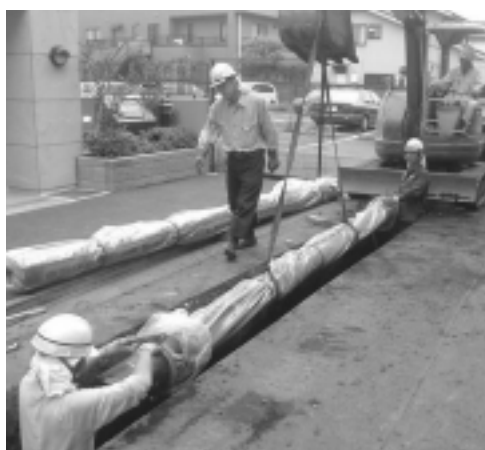
ダクタイル鋳鉄管の布設
