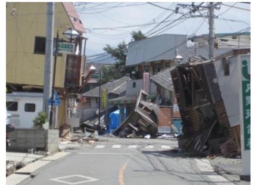
地震で損壊した建物
