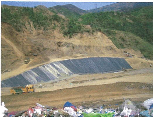
左（写真3）地面にビニールを被せここにゴミを集積するそうだ。
