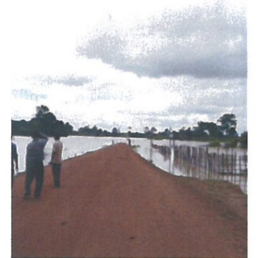
なくなった道路
