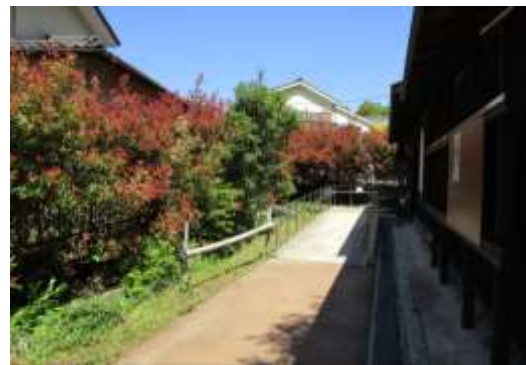
大沢二丁目古民家整備工事
