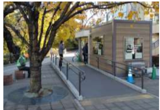
三鷹駅前緑の小広場公衆喫煙所整備工事
