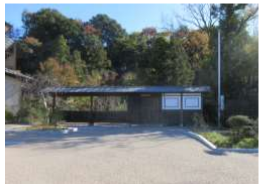
大沢の里駐車場等整備工事
