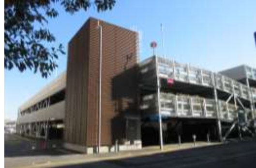
市民センター内駐車場新築工事
