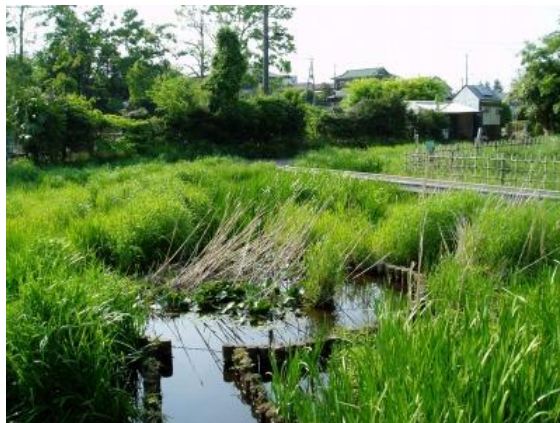
湿生花園：木道の改修
