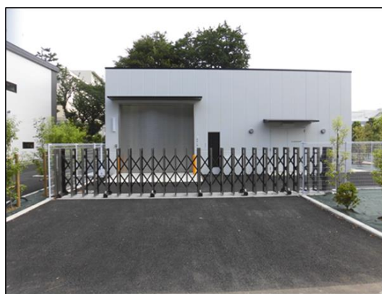
し尿投入施設
