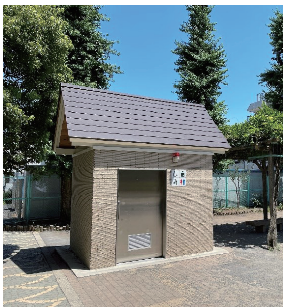
公園トイレの整備
