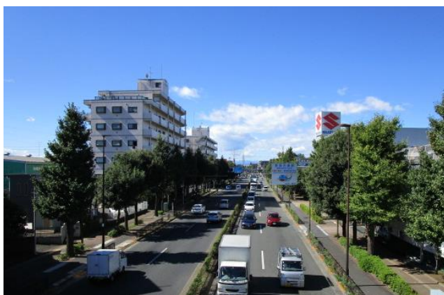
特定緊急輸送道路（東八道路）
