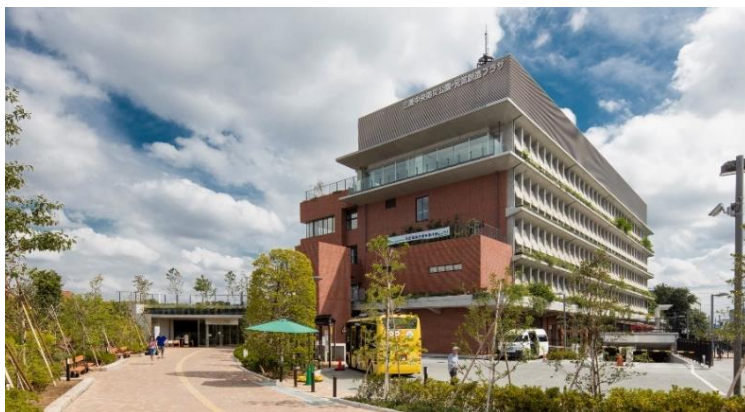
防災上重要な公共建築物（元気創造プラザ）
