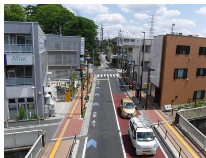
市道第 135 号線 (三鷹台駅前通り)
