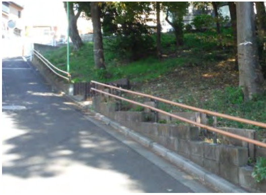
手すりを設けた坂道（中原）
