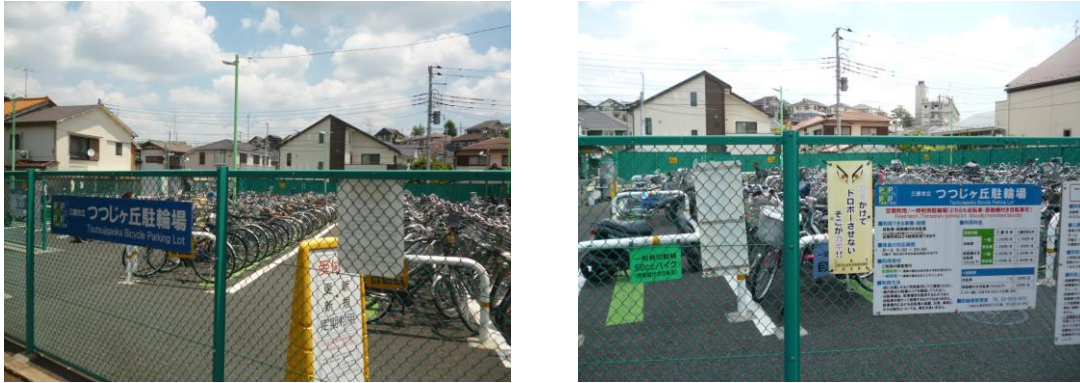
つつじヶ丘駐輪場の様子。平成 25 年（2013 年）の有料化に合わせて舗装等の整備を行っている。
