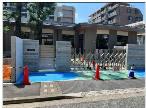
施設の外観(整備中)
