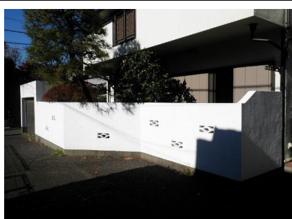
①敷地南側 敷地内の通路が未設置
