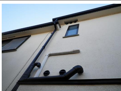
北側外構 雨水堅樋 排水施設に接続
