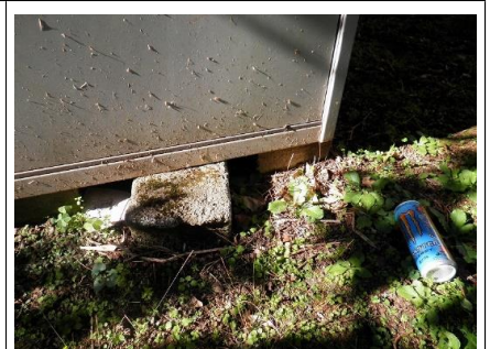
②物置の増築 緊結が必要な柱の脚部
