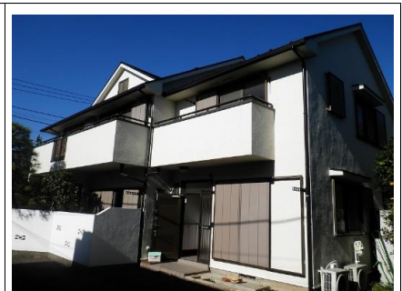
①南側外壁面 同左
