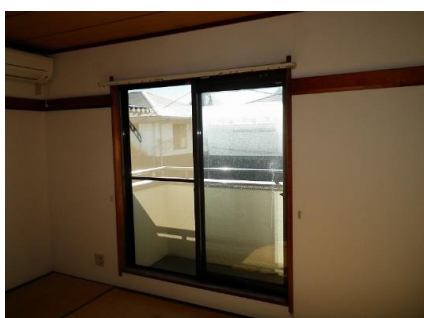
2階洋室(東側住戸) 採光上有効な窓
