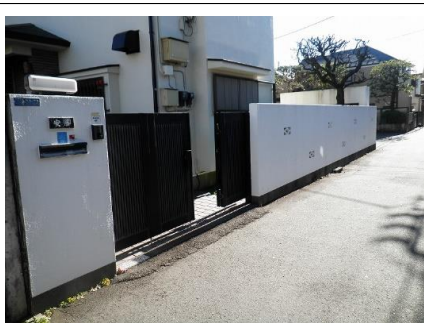
①西側門塀 道路内に設置されていた。
