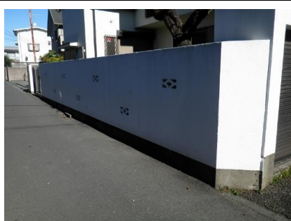
①西側コンクリートブロック塀 同左
