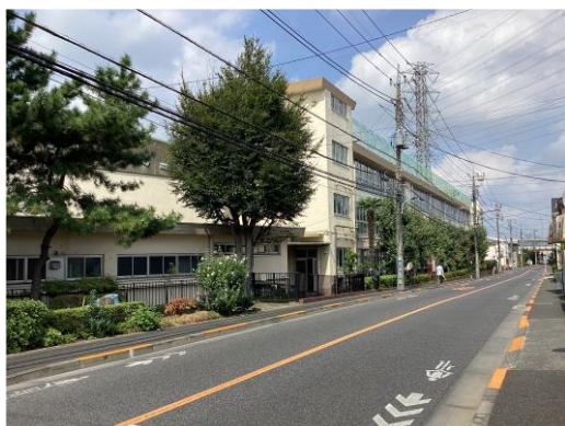
東側道路 1（都道 114 号線）
