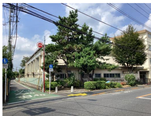
南・東側道路状況
